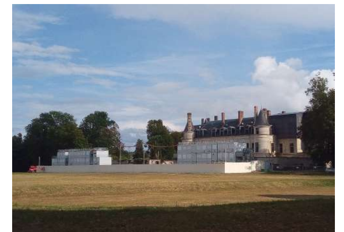
Chantier du Château
