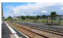
Mise en accessibilité de la gare de Villers Cotterêts - 2019
