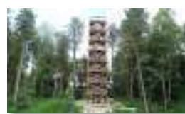
Réalisation de la Tour Mangin - 2018
