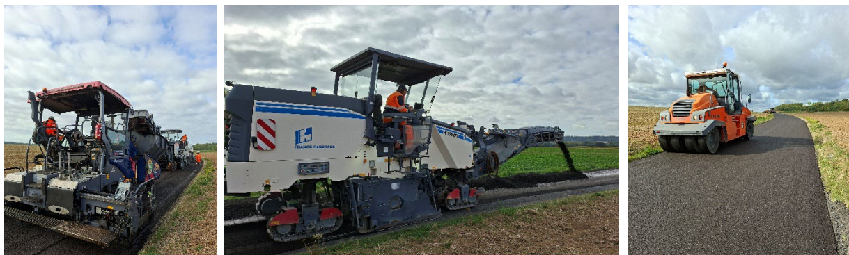
Travaux voirie VC 7 de Saint-Christophe-à-Berry à Vic-sur-Aisne_© CC Retz-en- Valois
