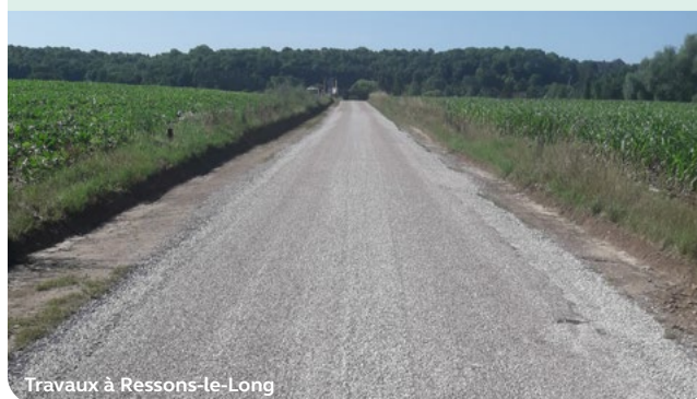
Travaux à Ressons-le-Long
