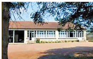
Salle du RPE Ancienne école rue Vaudrial
