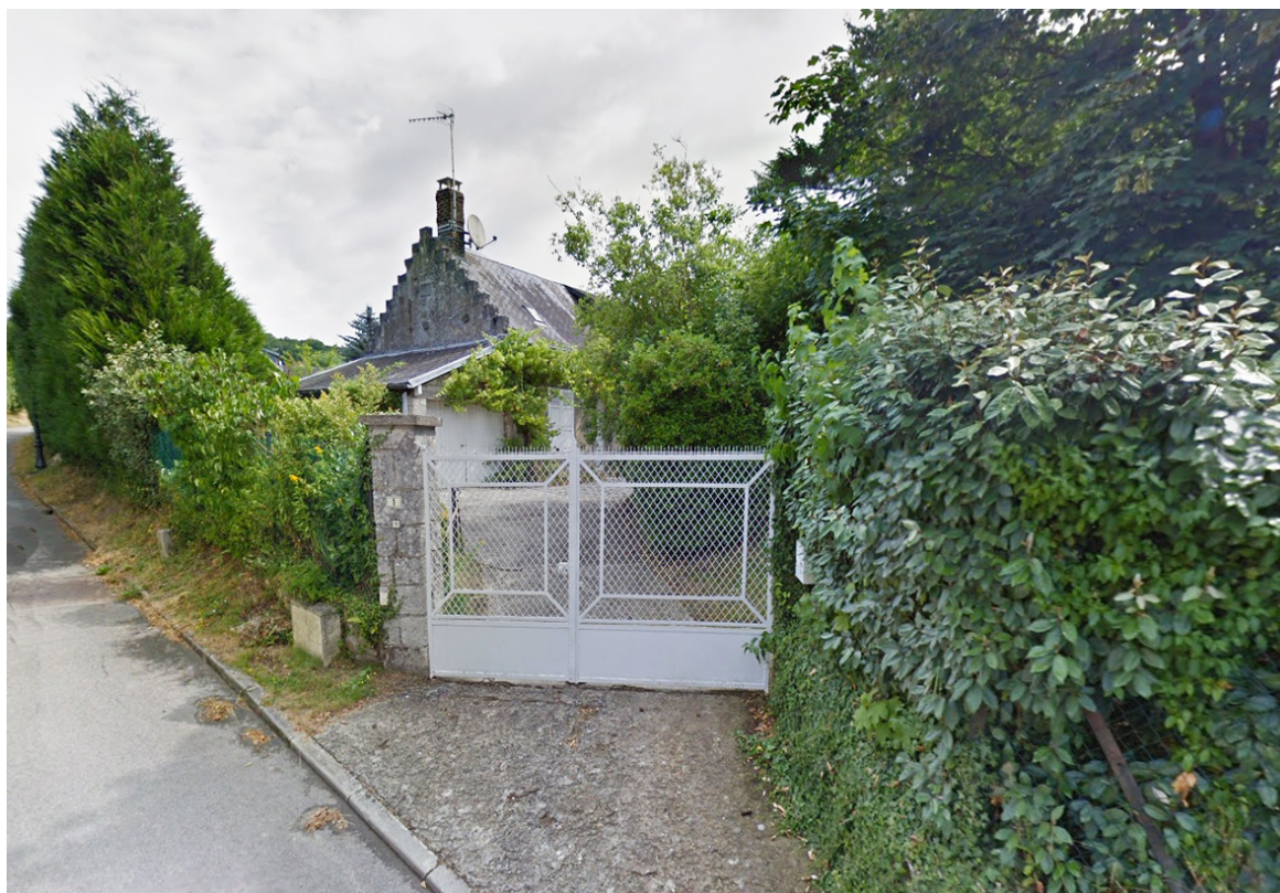
Vue sur le bâtiment situé sur la parcelle cadastrée OA 167 à Dampleux.
