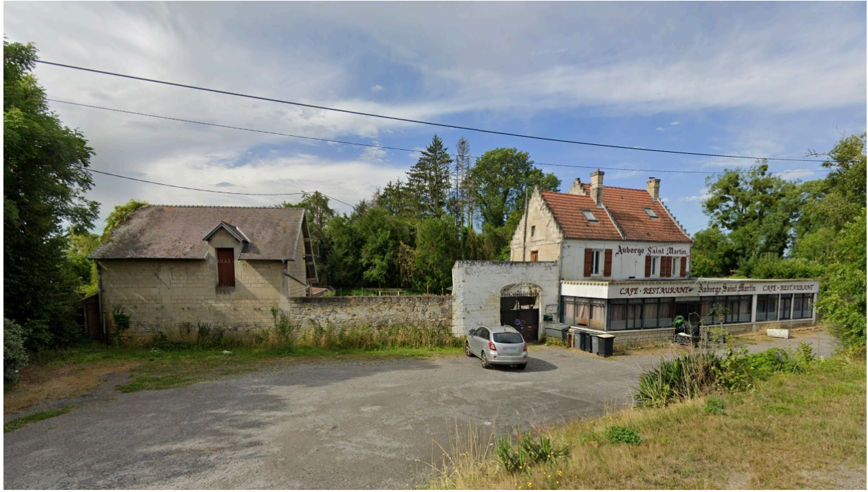
Vue sur les bâtiments existants sur les parcelles cadastrées section ZD n°83 et n°84 délimitées en zone agricole (A) au plan.
