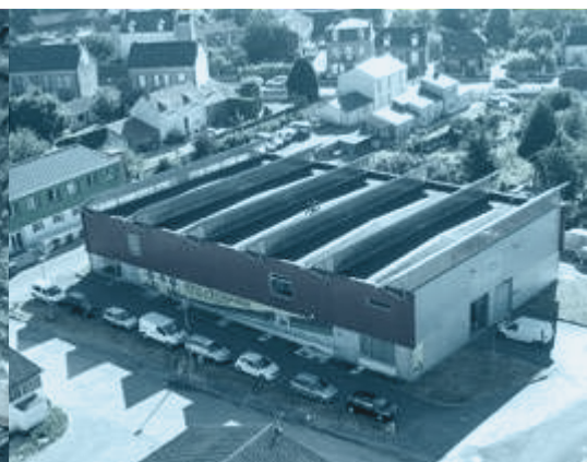
Hôtel d'entreprises à Villers-Cotterêts
