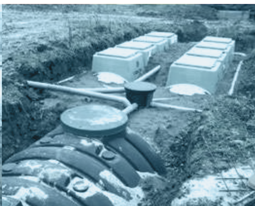
Chantier assainissement non collectif
