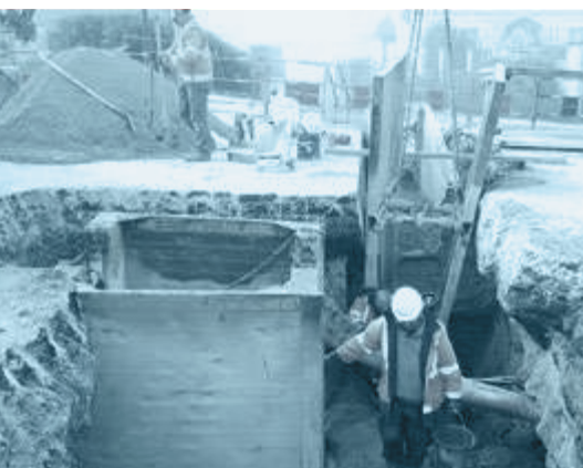
Chantier assainissement collectif
