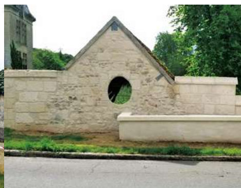
Lavoir de Cœuvres avant / après
