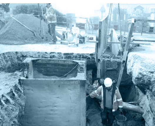
Chantier assainissement collectif
