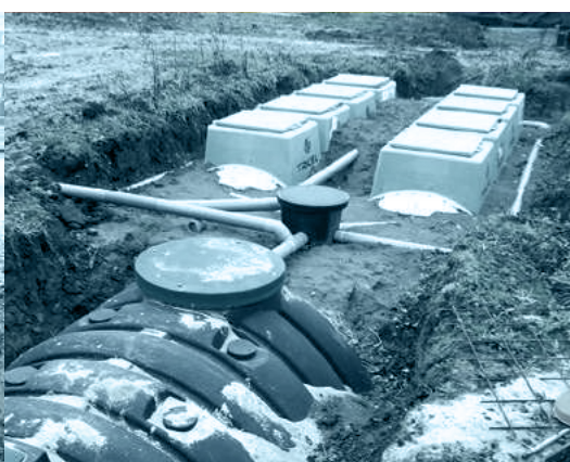
Chantier assainissement non collectif
