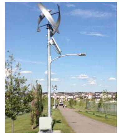
Eolienne à axe vertical, couplée à un panneau photovoltaïque pour l'éclairage public.
