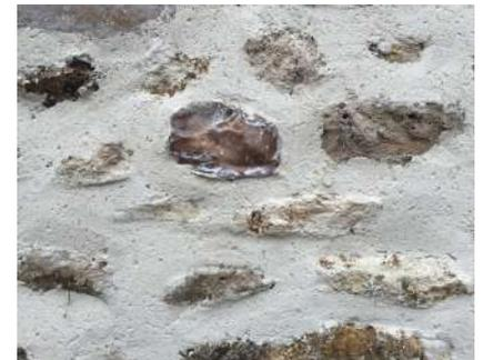
Joints très largement beurrés ne laissant que les têtes des silex et des pierres calcaires.
