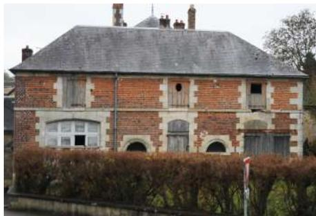
Remplissage de brique, encadrements de pierre de taille pour une construction néo-classique.
