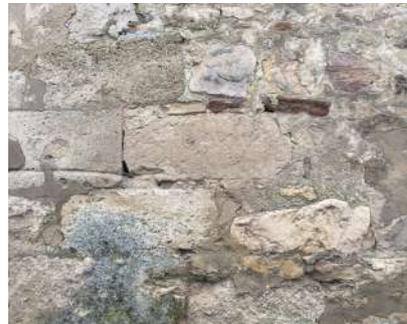
Maçonnerie mixte très présente dans le Valois : réparations et réemplois de pierres (calcaires et autres).
