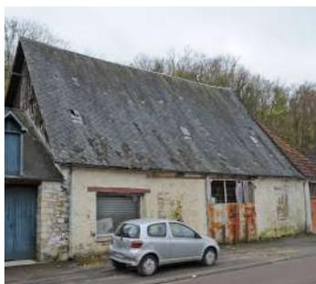
Toiture à forte pente (= adaptée à la tuile plate) couverte en grandes ardoises losangées en fibre ciment.
