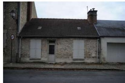
*Maison simple mais avec variation de largeur et répartition du nombre de trames et de leur espacement (trame de droite plus large) adapté à un aménagement intérieur plus sophistiqué que le logement ouvrier de base. A noter : les châssis de toit bien alignés sur les fenêtres.*
