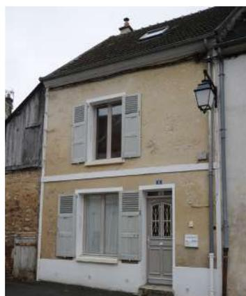
Enduit à la chaux épais et couvrant (quelques pierres vues) et coloration par sable pour aspect lisse sur une maison traditionnelle XIXe.
