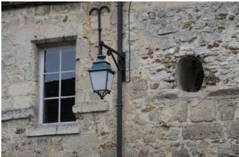
Différents appareillages de pierre et d'enduits (bandeaux et encadrements de fenêtre en pierre taillée, œil de bœuf maçonné) : les constructions sont modifiées au fil du temps.
